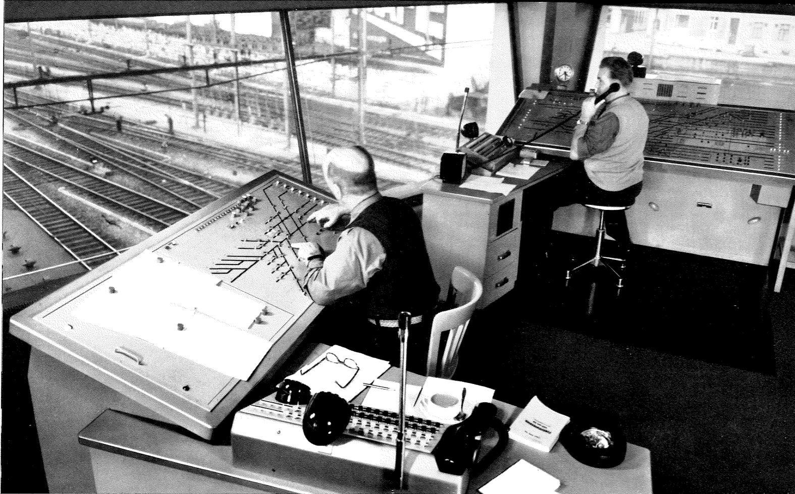
Vorn Rangierpult, dahinter Hauptstellpult
